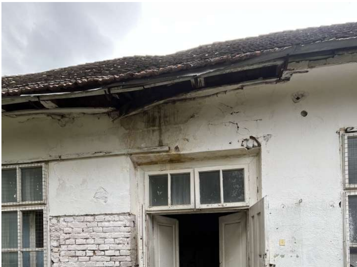
streasina degradata - cladire C2
