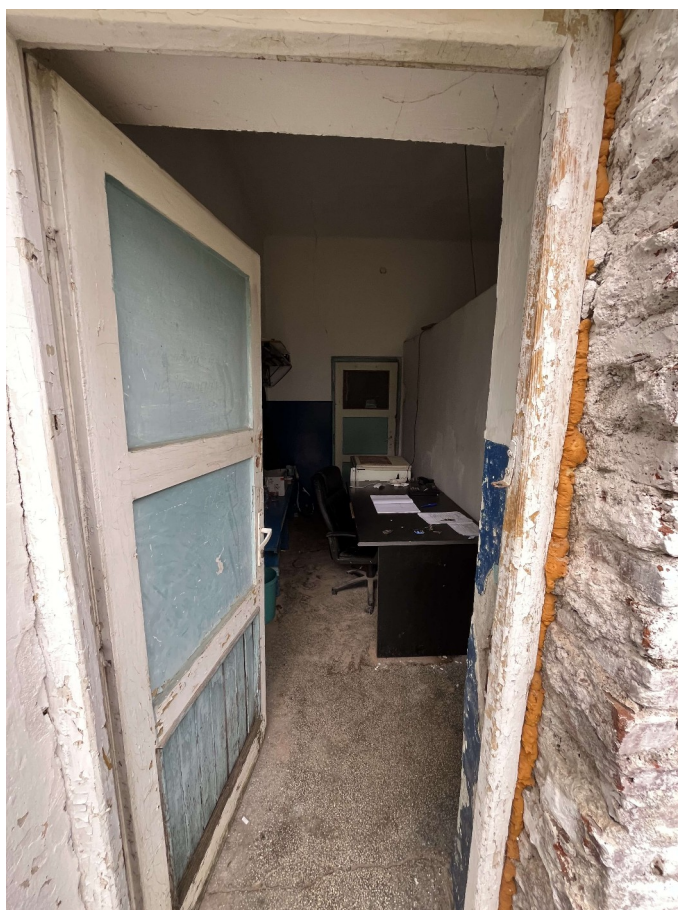
tamplarie degradata, neetansa - cladire C2
