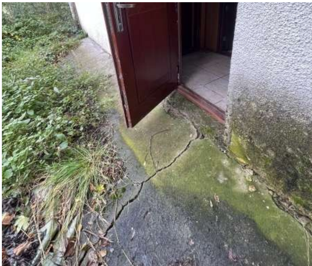
baza perete si trotuar degradat - cladire C3
