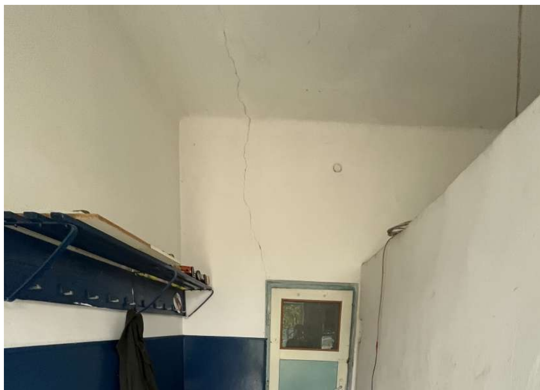
perete si planseu fisurat - cladire C2
